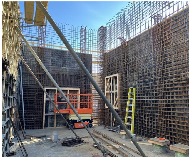
Photo 1: Headworks Wall Pour 1
